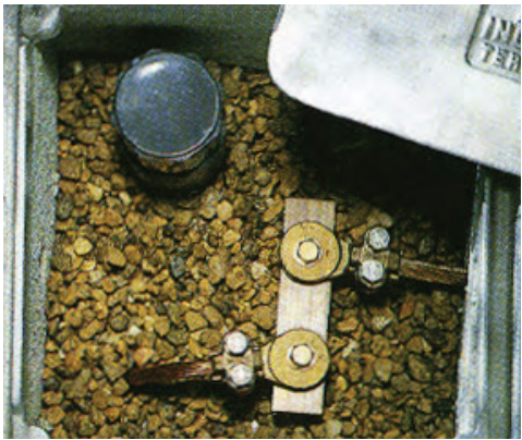
Fig. 13 – Secção transversal de uma ligação à terra.
